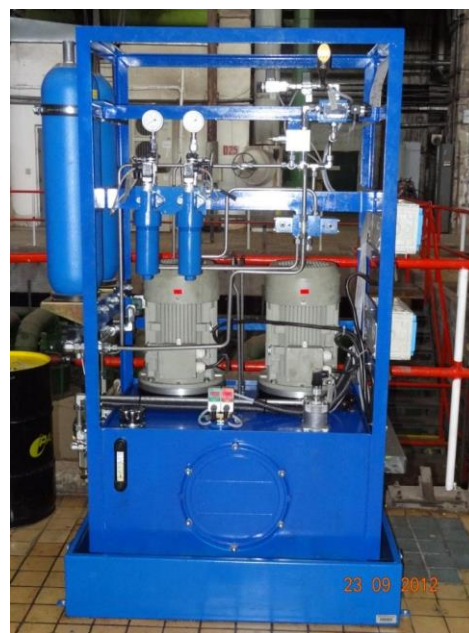
VT hydraulický agregát pro servopohony VT regulačních ventilů
