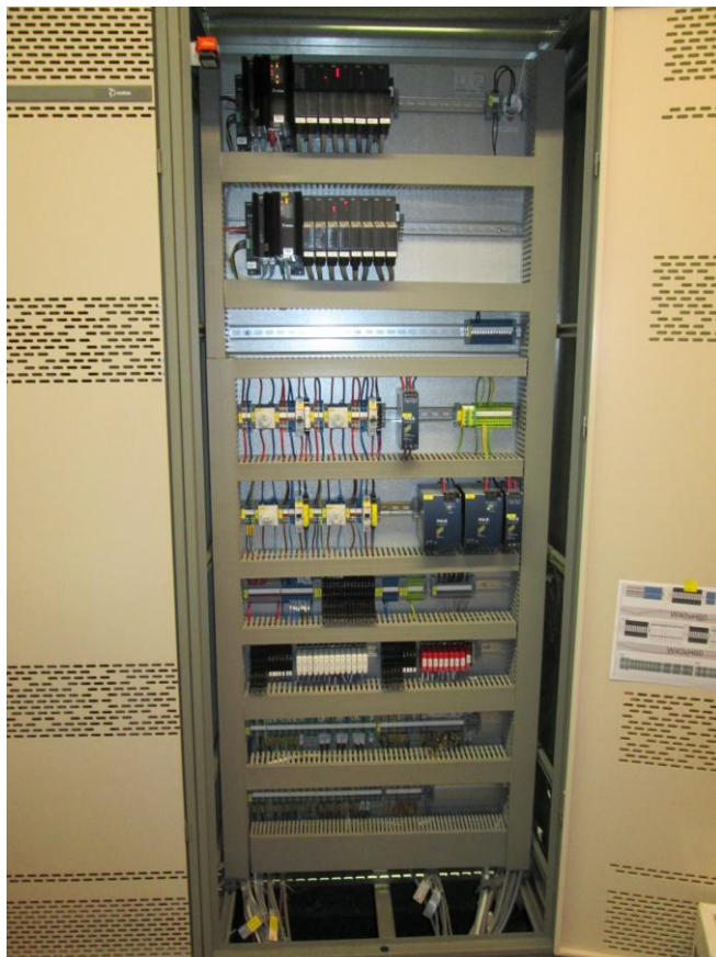
Řídicí systém METSO DNA
